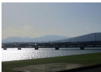
木曽川橋梁（尾張大橋）
